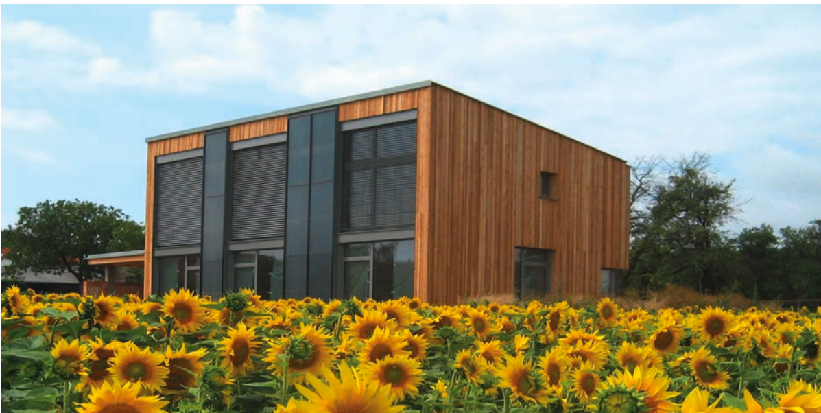
Solar house Oberduernbach, Austria
