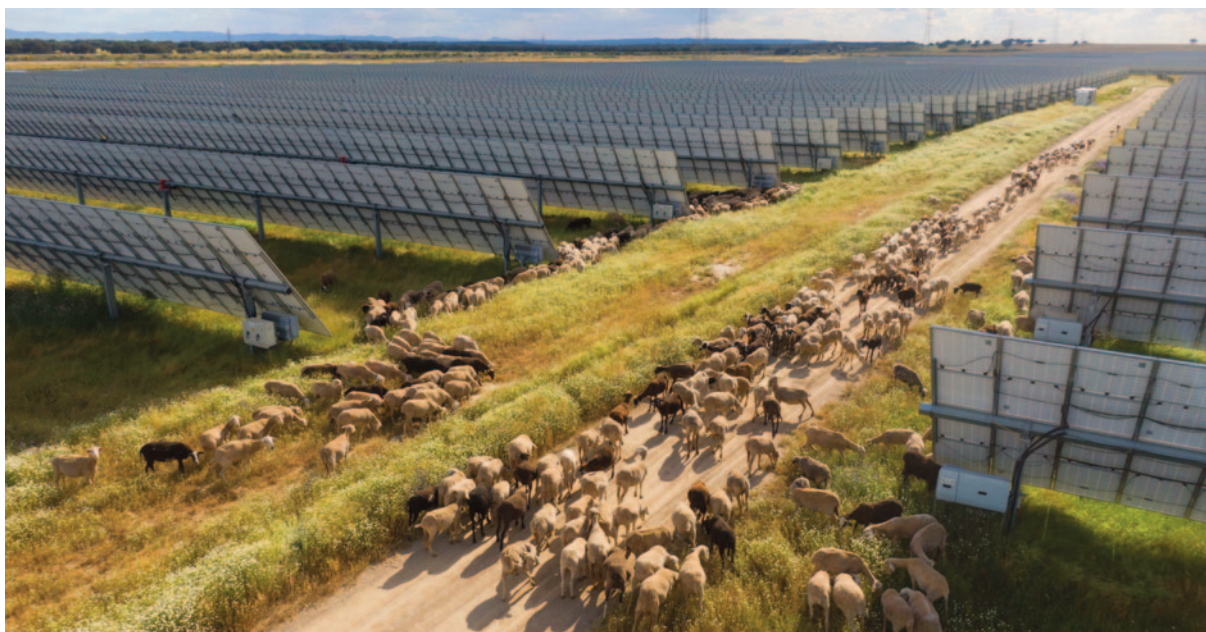
200 MW, Alcalá de Guadaíra, Seville, Spain.
